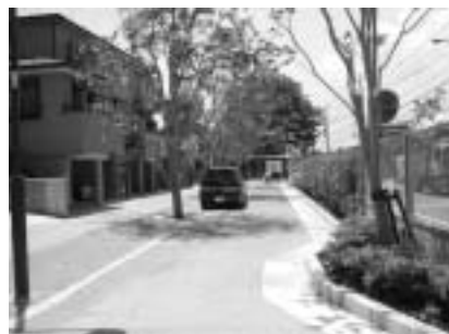
幅10mの環境施設帯モデル(歩行者用・自転車用が色分け)
